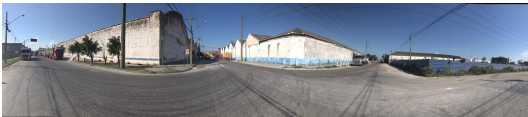
Foto 8 – Relatório fotográfico na AID
